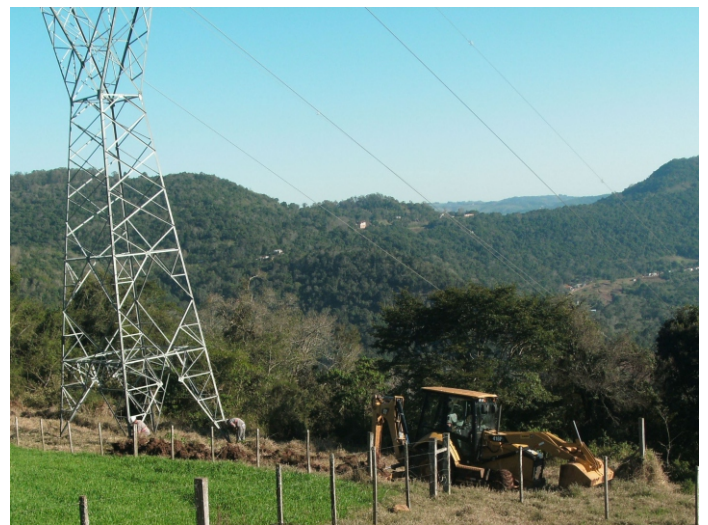
Serviços de manutenção das torres iniciaram no mês de julho, após constatação feita em inspeções semestrais
