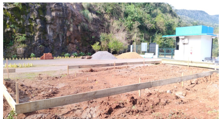
Construção do novo refeitório e sala de descanso pretende aumentar a satisfação e o bem-estar dos colaboradores
