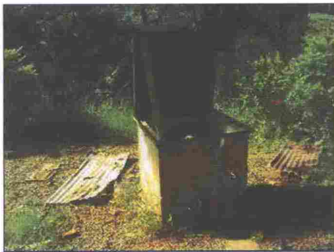
Vista do Poço – PM 1.
