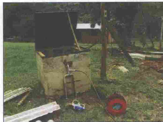
Vista do Poço – PM 2.
