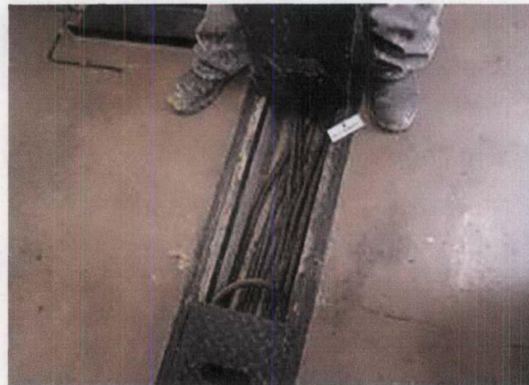
Caneleta no QSTA da tomada de Água
