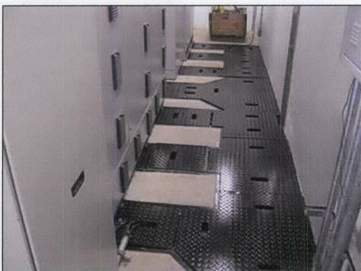
Vista da sala da Tomada d'água.
