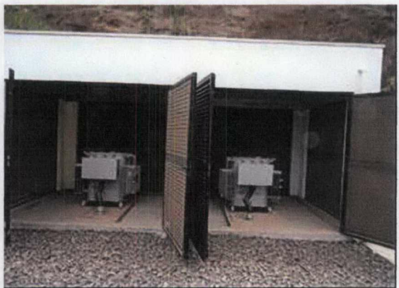
Sala dos transformadores na tomada d'Água
