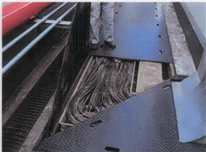
Nicho dos cabos de comunicação sendo inspecionado. Nota-se a presença das iscas em bom estado de conservação, não sendo necessária a substituição das mesmas.
