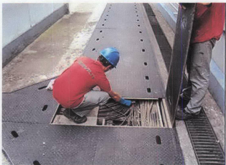
Vistoria sendo realizada nos nichos de passagem dos cabos de comunicação.
