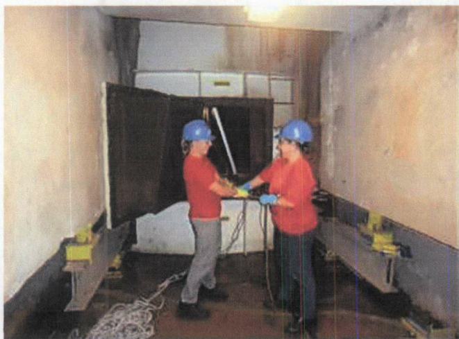
Vista da escotilha de entrada do tubo de sucção e montagem do tripé de resgate.
