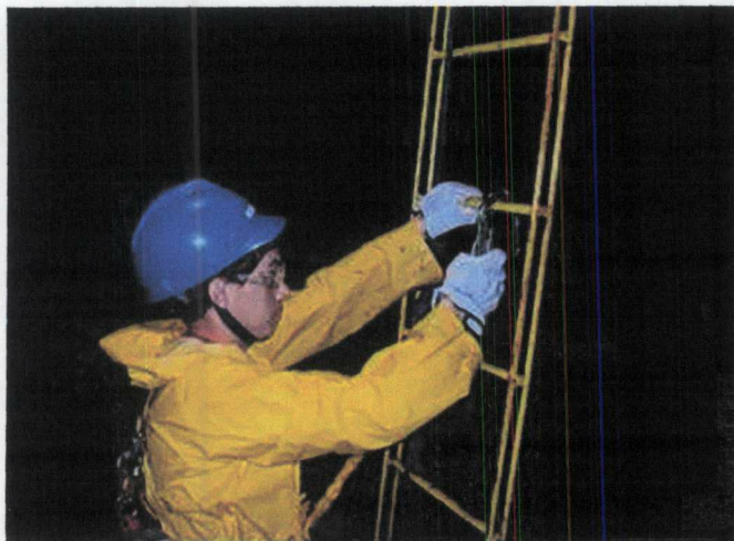
Utilização do cinto de segurança com trava quedas. Resgate dos peixes com auxílio de redes de arrasto, puçás e baldes.
