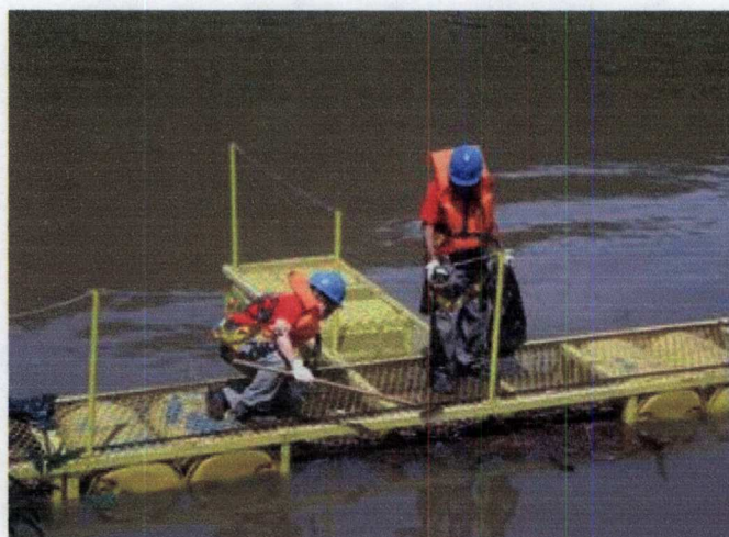
Remoção dos detritos e dos resíduos plásticos na parte interna do Log boom.
