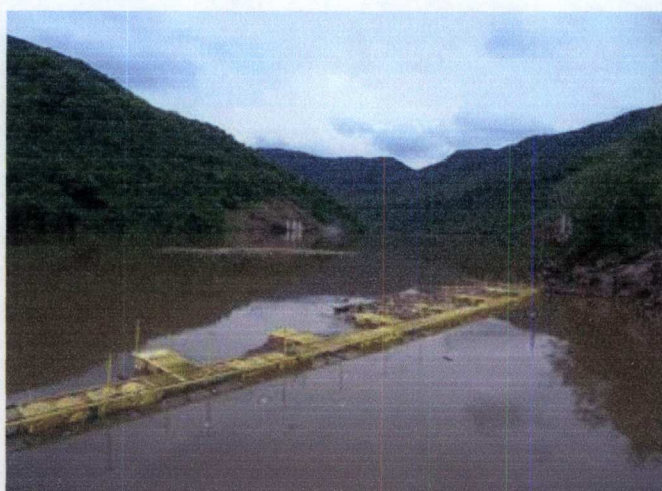
Detritos sendo removidos com as unidades geradoras desligadas. Ao lado nota-se o Log boom já limpo.
