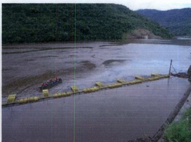
Detritos sendo removidos com as unidades geradoras desligadas. Ao lado nota-se o Log boom já limpo.
