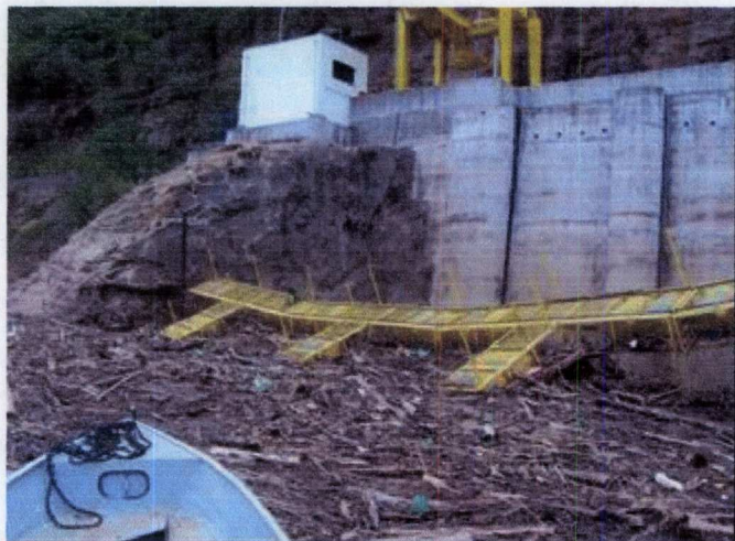
Detritos acumulados no Log boom. Nota-se que o mesmo encontrava-se suspenso devido a ação das fortes chuvas e do aumento da cota do reservatório alguns dias antes.
