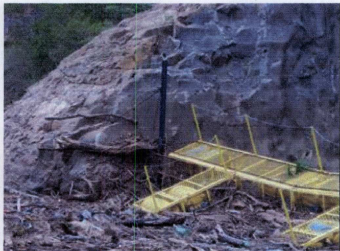
Detritos acumulados no Log boom. Nota-se que o mesmo encontrava-se suspenso devido a ação das fortes chuvas e do aumento da cota do reservatório alguns dias antes.
