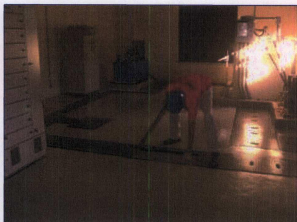
Colocação de sachês de raticida nos dutos de passagem dos cabos na sala do Vertedouro.
