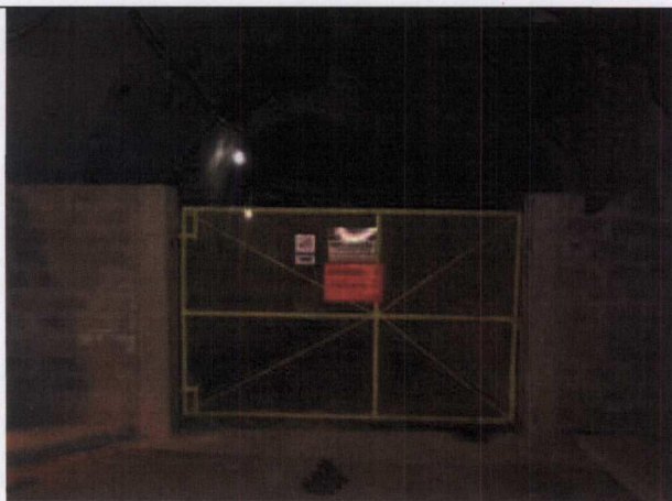
Túnel do tampão.
