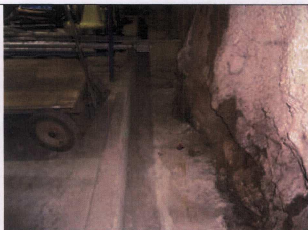
Aplicação de klerat nas canaletas do almoarifado.
