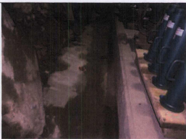
Canaleta do Almojarifado.
