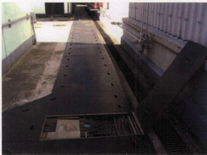
Nicho dos cabos de comunicação. Observa-se a aplicação do raticida neste local.
