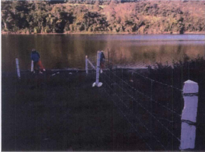
Construção de cercas na UHE 14 de Julho. No detalhe observa-se a base dos postes concretado.
