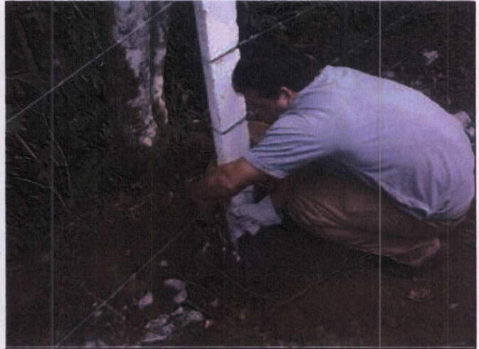
Construção de cercas na UHE 14 de Julho. No detalhe observa-se a base dos postes concretado.
