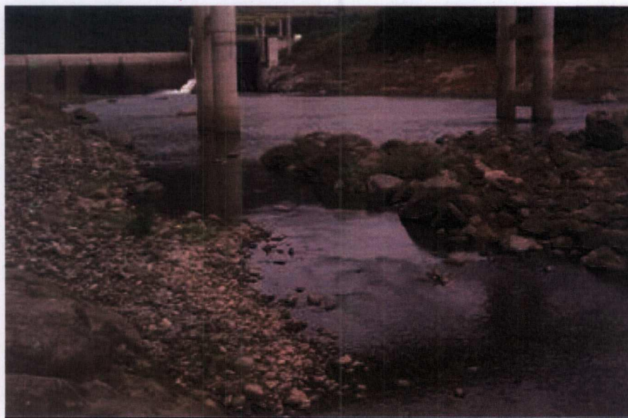
Ponte de serviço da Ceran – UTM 437.584 / 6.784.949
