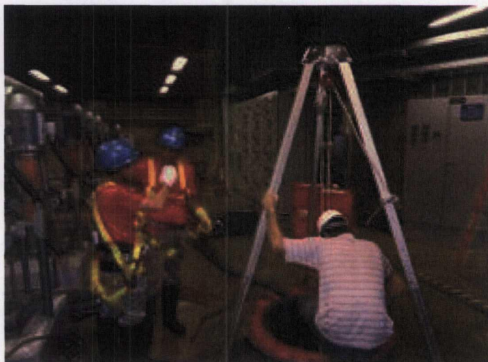
Montagem do tripé de segurança para espaços confinados, conforme PO-CC-MA-003.
