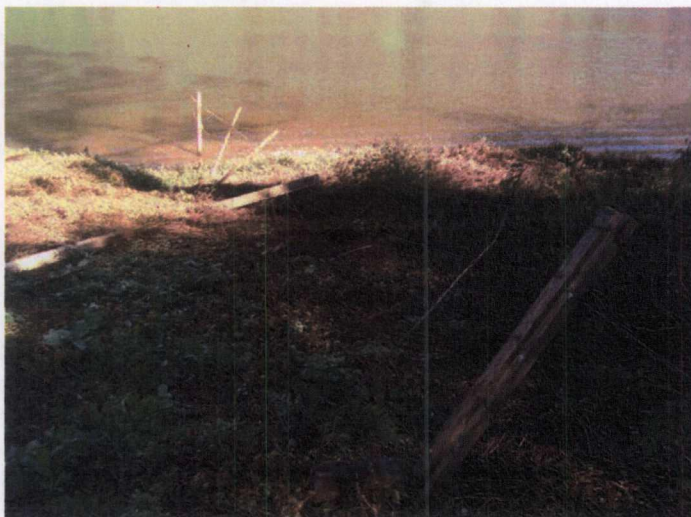
Gleba D-084: cerca do corredor de dessedentação danificada
