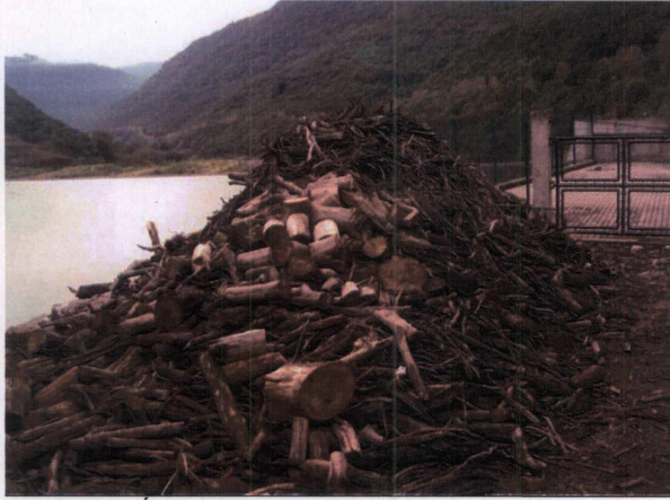
Tomada de Água: resíduos acumulados em local inadequado.
