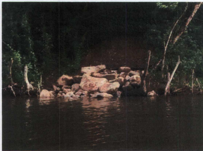
Vista parcial do desmatamento e construção de trapiche com matoções na APP.
