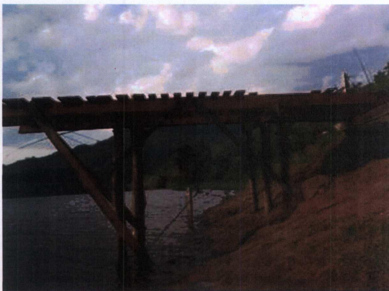
Gleba D-073: trapiche fixo sendo construído no corredor de dessedentação.
