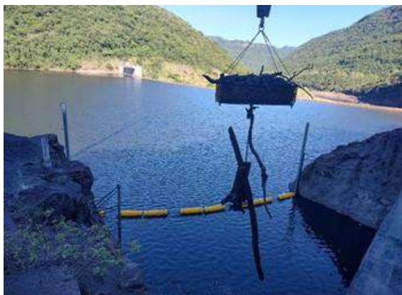
O material removido apresenta uma grande infestação de mexilhões.
