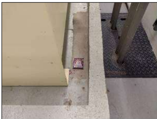
Sala do Vertedouro
