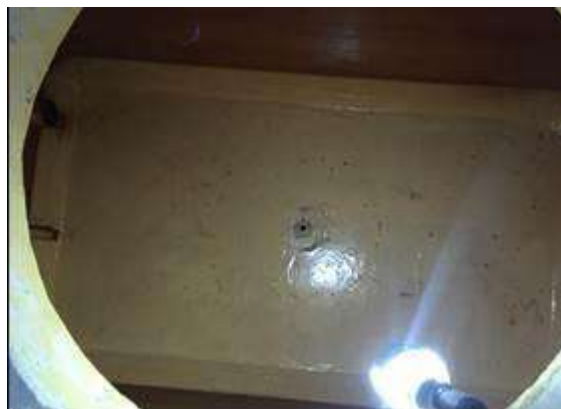
Reservatório sendo limpo. Ao lado observa-se um dos reservatórios após a limpeza.
