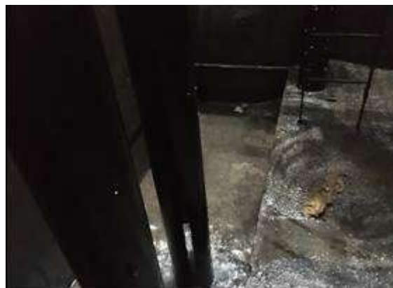
Bombas de drenagem sujas com pontos de oxidação e sem vestígios de mexilhão dourado.
