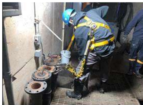
Bombas de drenagem sendo realizada manutenção.
