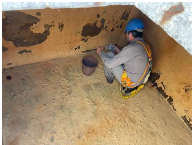
Exemplo da limpeza realizada em reservatório superior (antes e depois).
