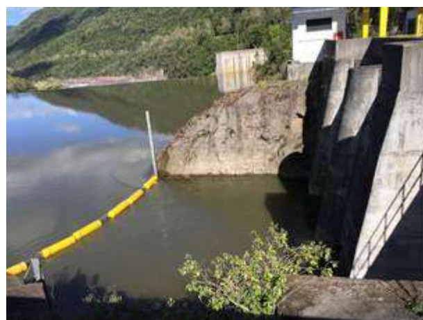
Vista do log boom depois da atividade de limpeza.
