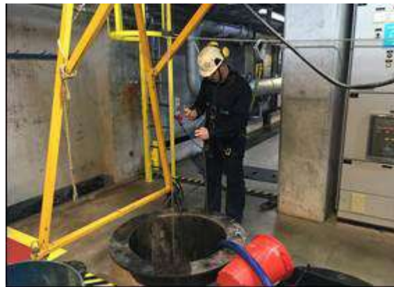
Instalação dos equipamentos, iluminação e medição de gases.
