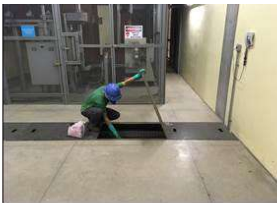
Verificação de ações dos Roedores na Subestação Associada
