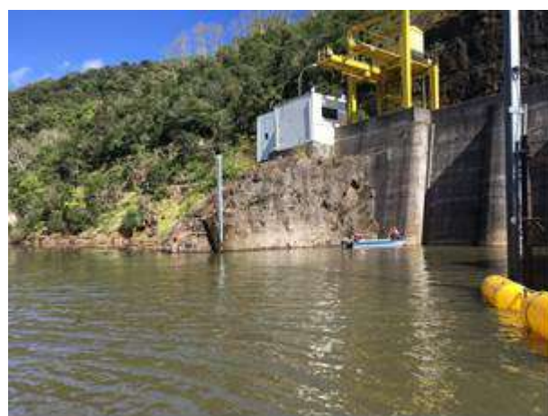
Retirada do material da tomada d'água e direcionamento para a barragem aproveitando o vertimento.
