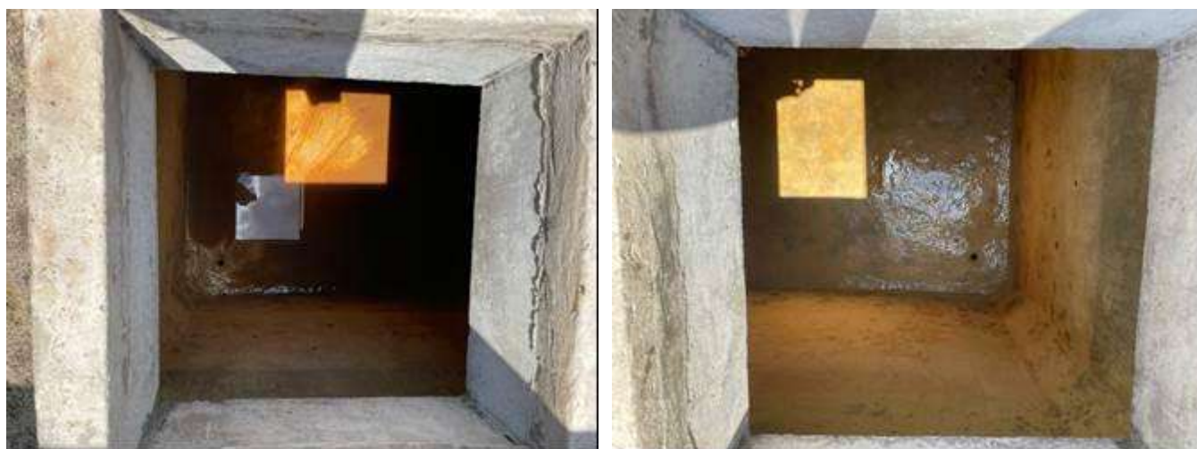
Exemplo da limpeza realizada em reservatório superior (antes e depois).
