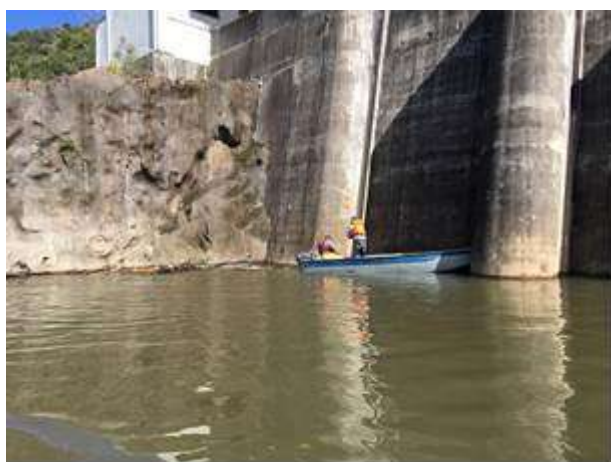
Retirada do material da tomada d'água e direcionamento para a barragem aproveitando o vertimento.
