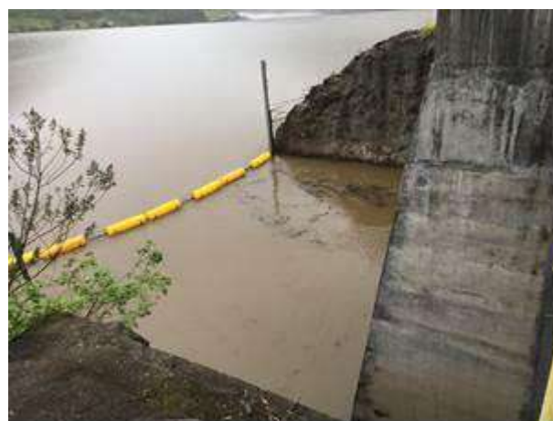
Vista do log boom depois da atividade de limpeza.
