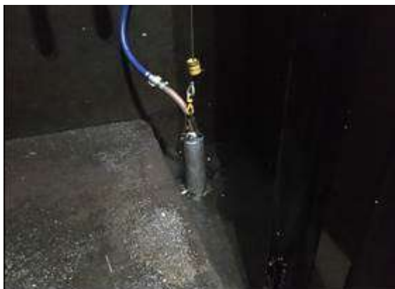
Bombas de drenagem sujas com pontos de oxidação e sem vestígios de mexilhão dourado.
