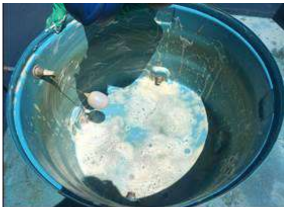
Reservatório sendo limpo. Ao lado observa-se o reservatório após a limpeza.
