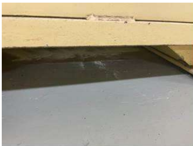
Sala do Vertedouro.
