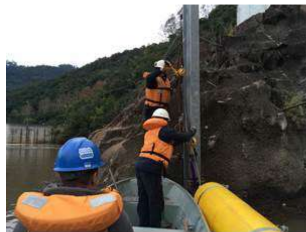
Abertura de uma das extremidades para retirada do material junto as grades da tomada d'água.
