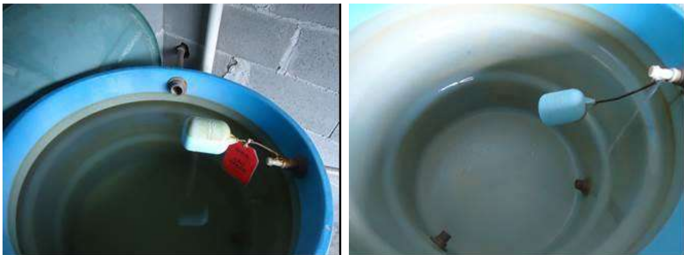
Exemplo da limpeza das caixas.
