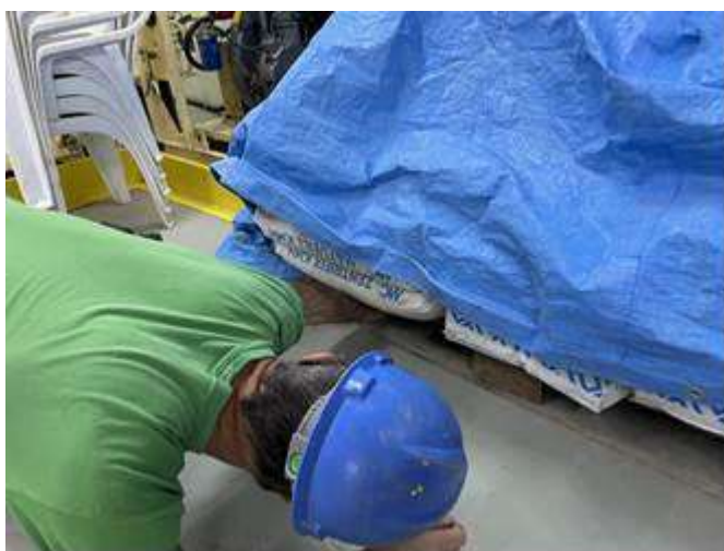
Aplicação na sala do vertedouro.
