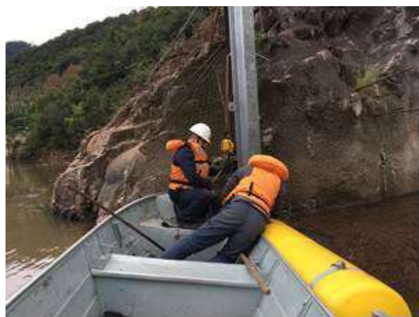
Abertura de uma das extremidades para retirada do material junto as grades da tomada d'água.
